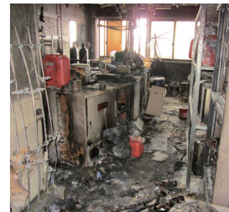
揺れによる化学実験室の火災跡（東北大学）
