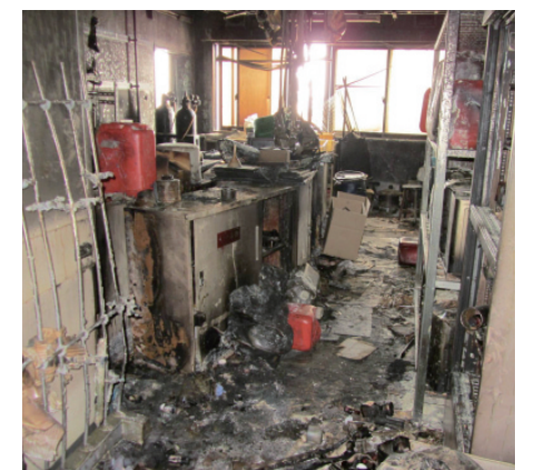
揺れによる化学実験室の火災跡（東北大学）
