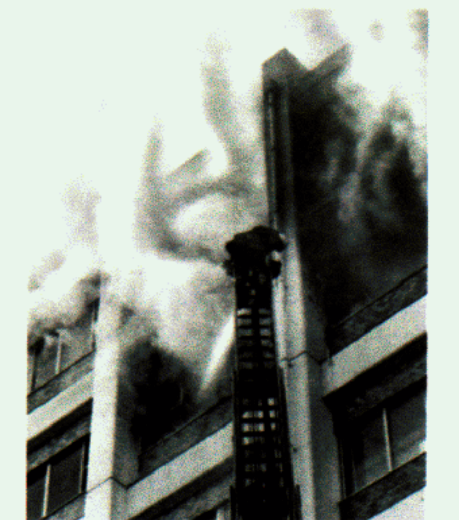
1978年宮城県沖地震による東北大学理学部化学棟の火災（河北新報社提供）
