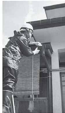
図10. 雨樋の詰まりを掃除している様子
