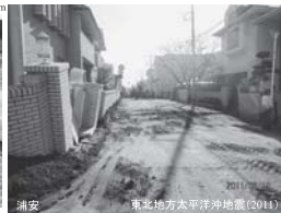
2011年 津安 東北地方太平洋沖地震(2011) 液状化後の沈下量は噴砂量と等しいわけではない。
