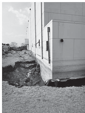
構造物周りの洗掘(主に津波の下流方向に発生)
