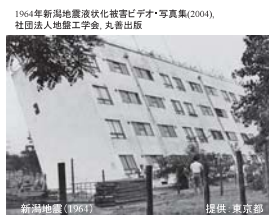
新潟地震(1964) 提供: 東京都 液状化研究が盛んとなるきっかけとも言える新潟地震でのアパートの転倒。貯水タンクや階段など、重心の重い方へほとんどのアパートが傾いた。
