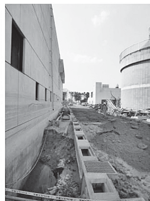
構造物周りの洗掘(主に津波の下流方向に発生)
