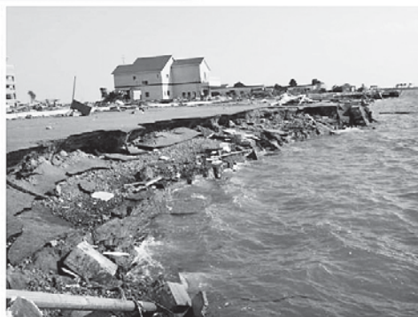
浸食された護岸(巨理町荒浜地区)
