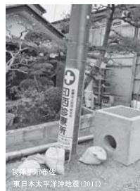
我孫子市布佐 東日本太平洋沖地震(2011) 2m近くの沈下、電柱のように、根入れの浅い構造物は傾きながら沈下する。
