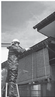
図10. 雨樋の詰まりを掃除している様子
