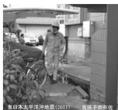
東日本太平洋沖地震(2011) 我孫子市布佐 液状化に伴う周辺地盤の沈下によって生じたマンションとの段差
