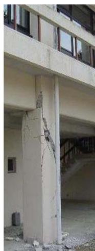
2階建て校舎の1階ピロティの柱がせん断破壊
