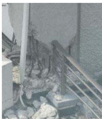
高層校舎の3階の柱の破壊
